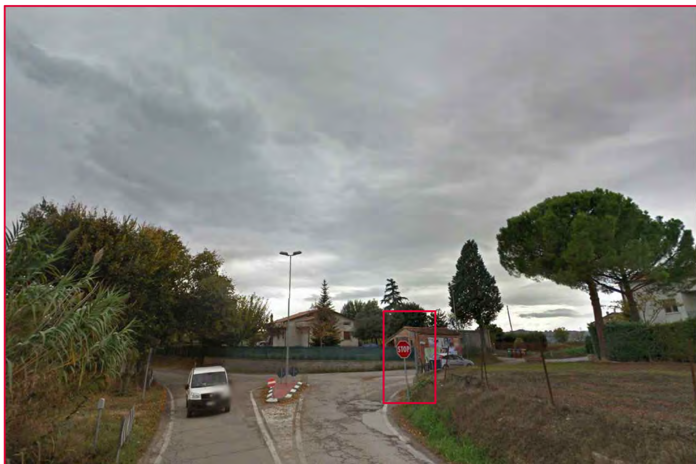
IMM. 2 POSIZIONAMENTO IMPIANTO SEMAFORICO - B SOTTOCANTIERE 1
