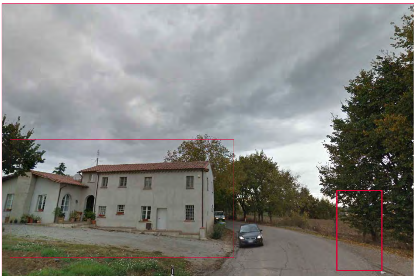
IMM. 3 POSIZIONAMENTO IMPIANTO SEMAFORICO - C SOTTOCANTIERE 1
