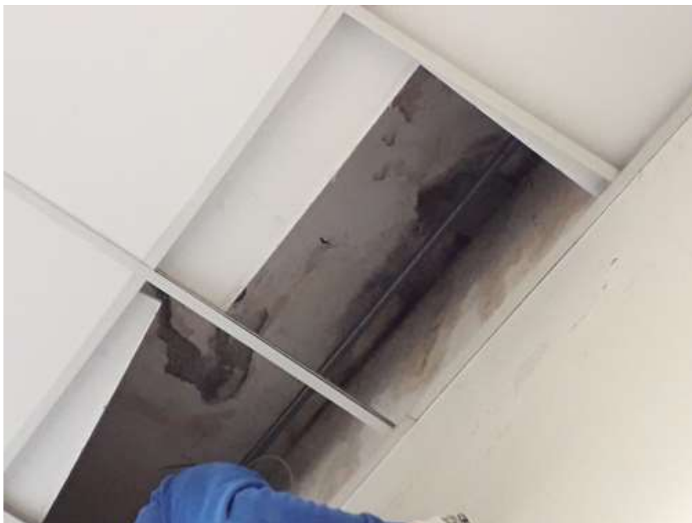
Infiltrazioni livello del primo impalcato
