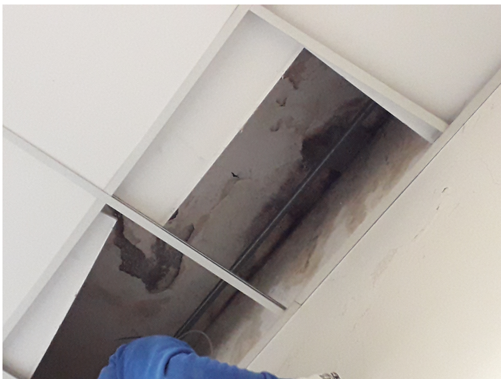
Infiltrazioni livello del primo impalcato
