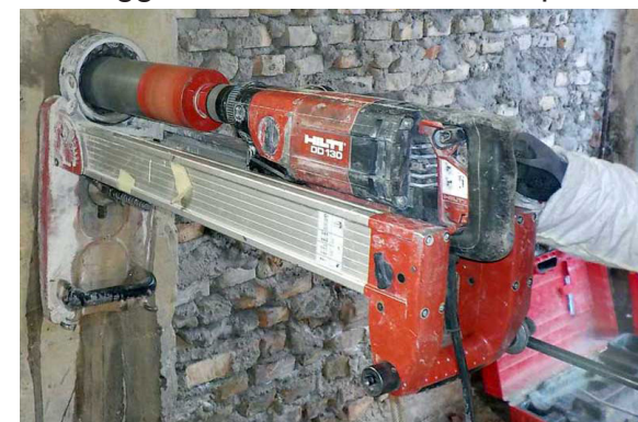
strumento per la realizzazione di un carotaggio continuo
