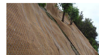
esempi di realizzazione di geogriglie
