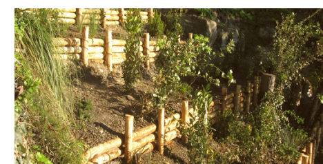
esempi di realizzazione di palizzata viva
