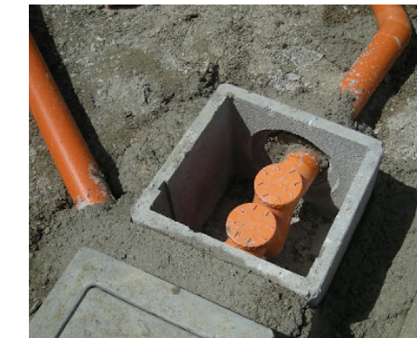
tubi in pvc di raccordo tra pozzetti
