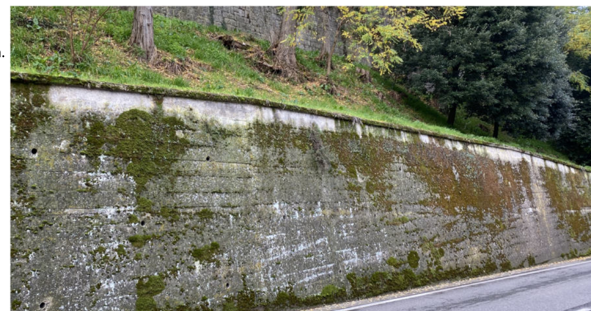
Intervento di pulitura sul paramento murario esistente
