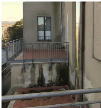
Infiltrazioni solai primo livello
