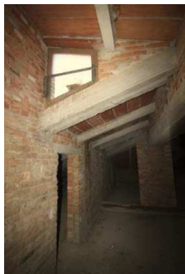
Interventi 78-81 Copertura in tavelloni e travetti varesi.
