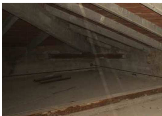
Interventi 78-81 Copertura in tavelloni e travetti varesi.
