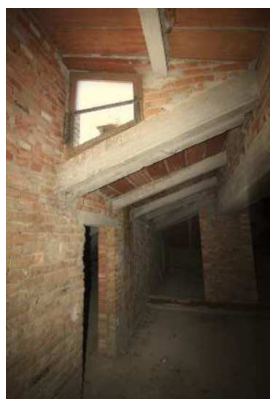
Interventi 78-81 Copertura in tavelloni e travetti varesi.
