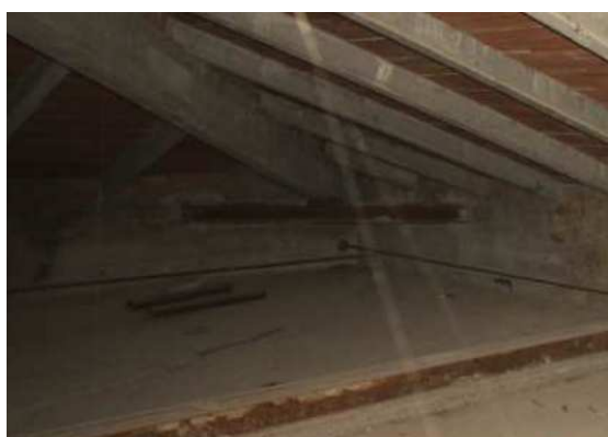
Interventi 78-81 Copertura in tavelloni e travetti varesi.
