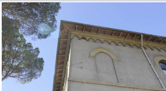
Vista Cornici – Aperture Tamponate
