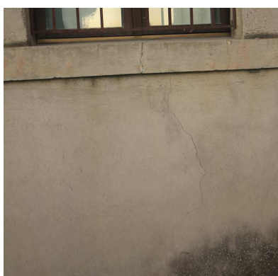
Stato di degrado intonaci
