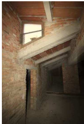
Interventi 78-81 Copertura in tavelloni e travetti varesi.
