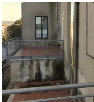
Infiltrazioni solai primo livello
