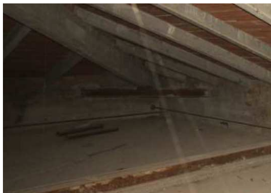
Interventi 78-81 Copertura in tavelloni e travetti varesi.
