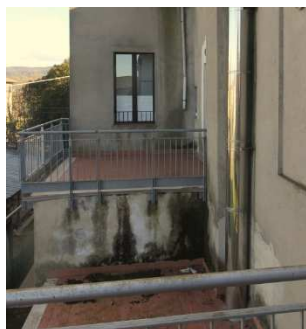
Infiltrazioni solai primo livello
