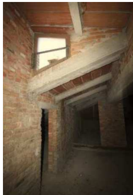
Interventi 78-81 Copertura in tavelloni e travetti varesi.
