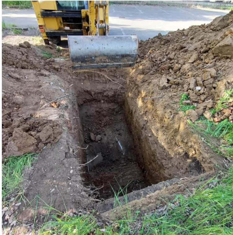
Saggio per tracciamento condotta esistente
