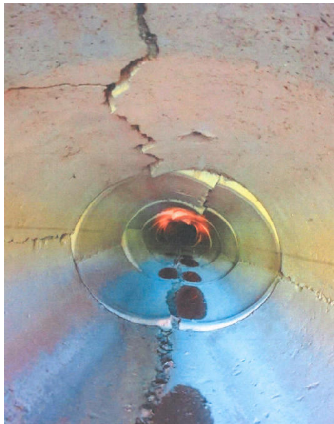
Fosso Piscinello – Cedimento della tubazione autoportante
