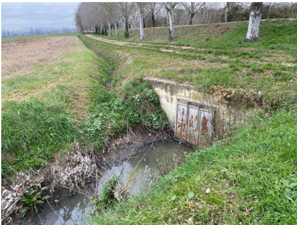
Sbocco della tubazione oltre l'argine di difesa idraulica con paramento in cls e valvola clapet
