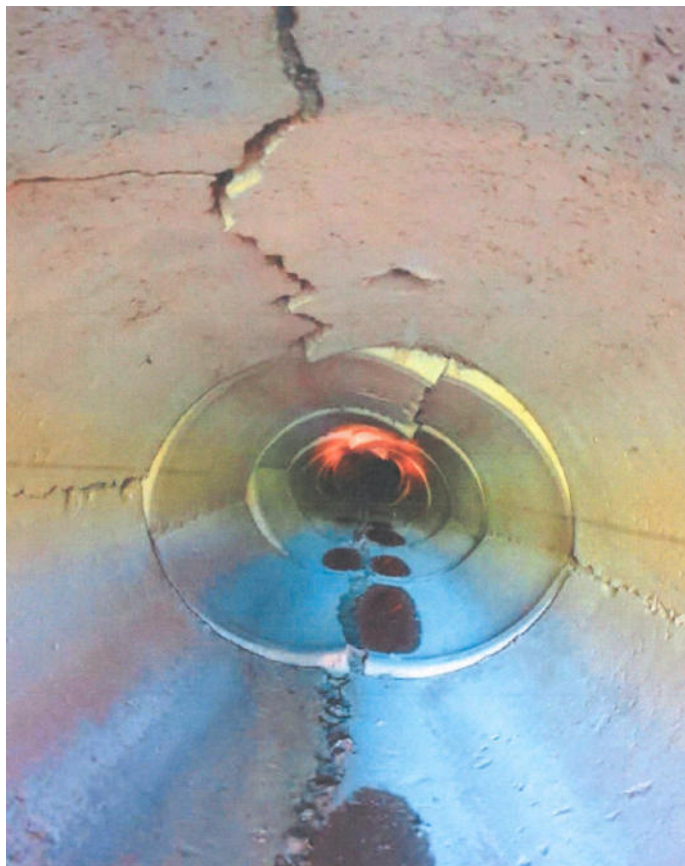
Fosso Piscinello – Cedimento della tubazione autoportante
