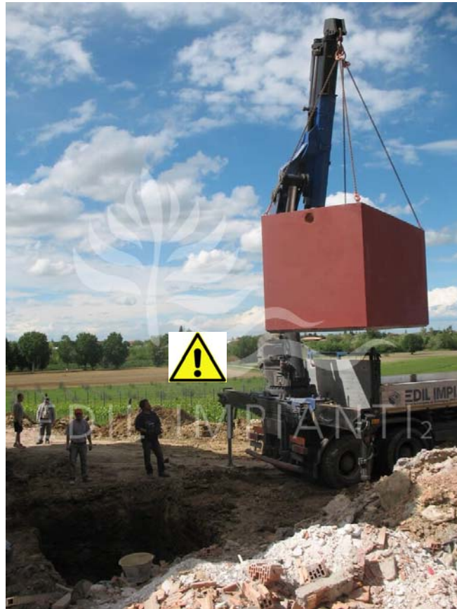
Figura 8 - visione della situazione tipo da non imitare: lascare sempre protezioni contro caduta dall'alto, uso DPI
